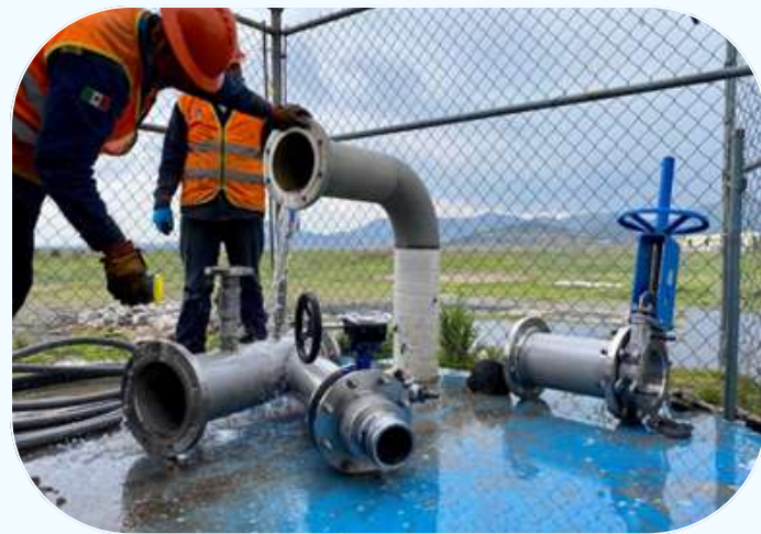
Perforación y Construcción de Pozos
